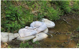
湧水を土嚢でせき止め塩ビからの水量を計測
